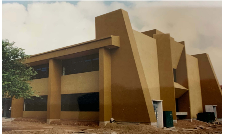
Avances de la construcción de la UTAB 1997
