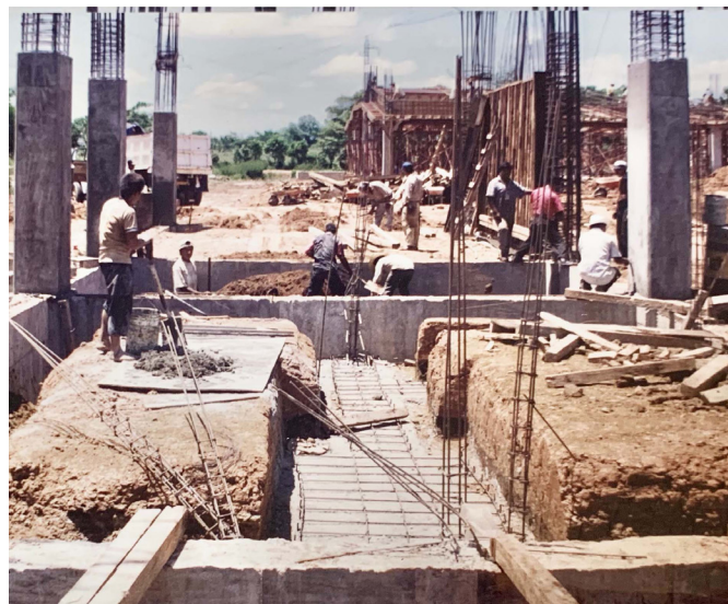
Construcción de la UTTAB 7 de agosto de 1997
