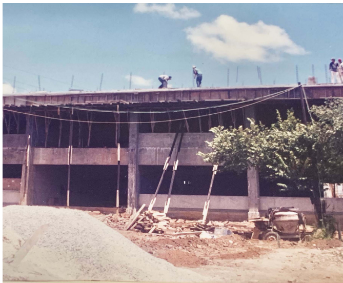
Construcción de la UTTAB 7 de agosto de 1997
